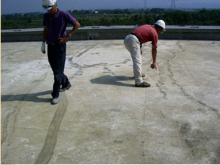
屋頂樓板裂縫滲水處理
